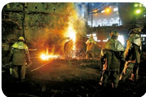
▲高炉改修時のランス切断解体作業
