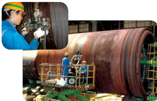
▲ TOFD 法による压力容器創設部検査
