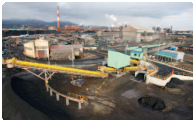
▲プラント設備据付
