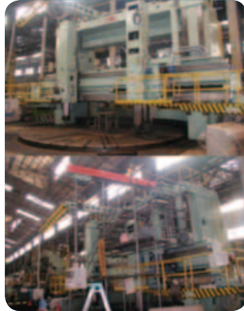
▲大型特殊盤解体移設工事
