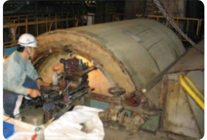
▲バルブ洗浄ドラムシート面現地加工
