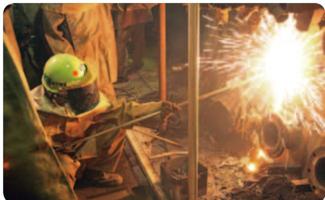
▲高炉改修ランス切断
