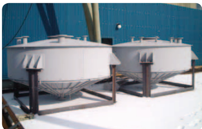
▲タール安水タンク
