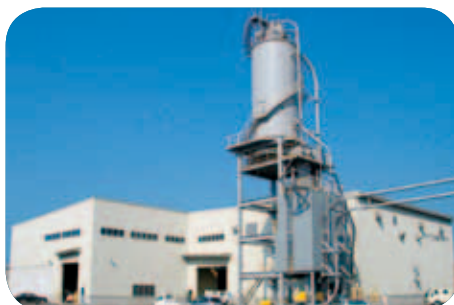
▲リサイクル燃料センター(廃プラスチック処理設備)
