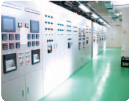
▲各種制御盤製作
