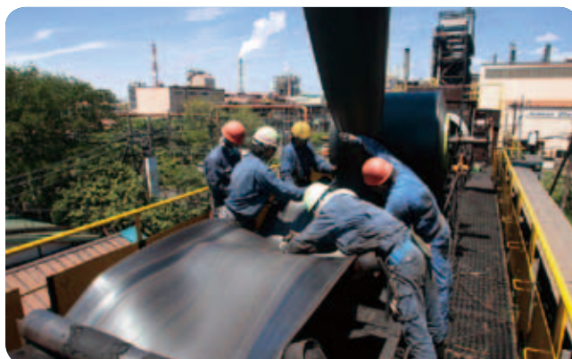
▲ベルトエンドレス施工
