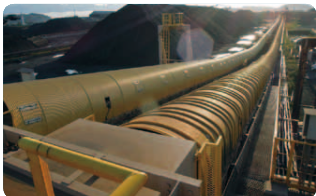
▲コンベヤ製作据付
