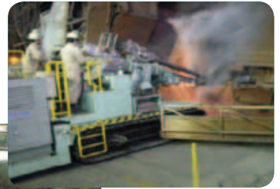
▲転炉出鋼孔煉瓦解体工事
