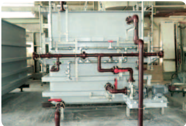
▲ FRP 製メッキ槽 配管
