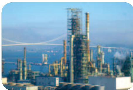
▲ナフサ水素化精製装置
