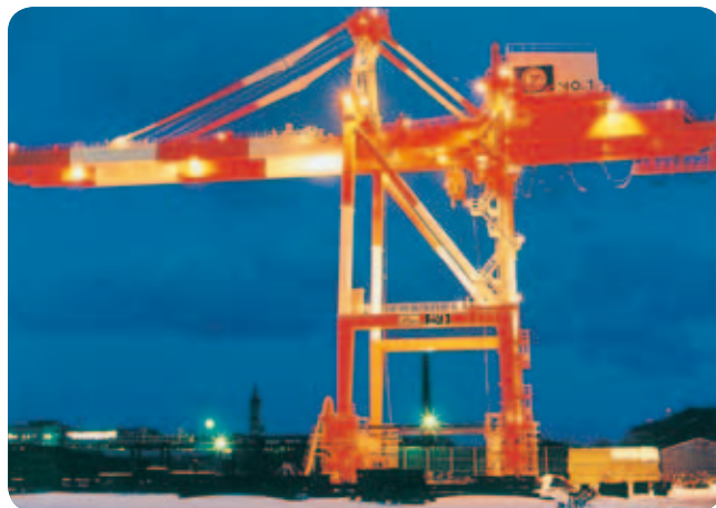
▲ローボトリ式橋形クレーン
