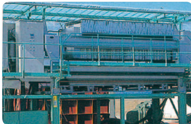
▲水処理装置（高圧薄層フィルタープレス）
