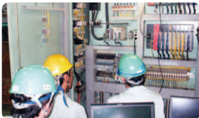
▲設備の試運転・試験
