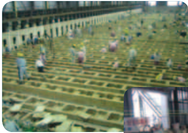
▲燃焼室煉瓦積
