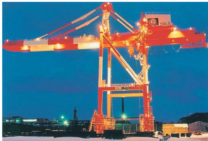
▲ロープトロリ式橋形クレーン
