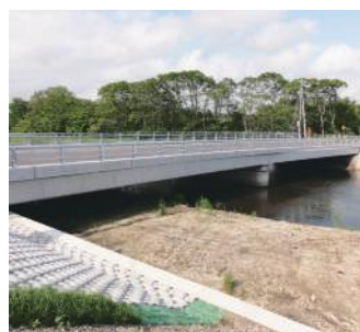
H20設計：苫小牧市 植苗橋 (発注：苫小牧市)
