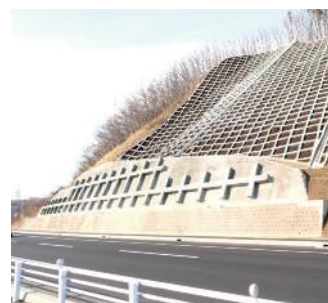
H24設計：室蘭市 崎守法面 (発注：室蘭開発建設部)
