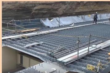
合成床版の内部欠陥を効率的かつ定量的に判断できる非破壊検査方法の研究開発を実施。
