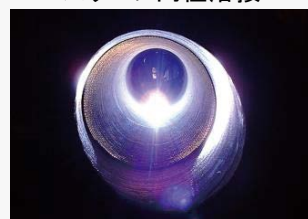
スリーブ内径溶接
