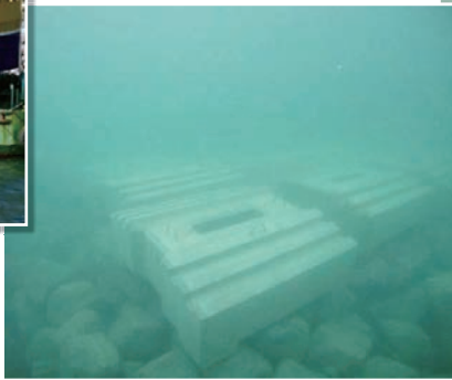
海底に設置された水和固化体ブロック▼
