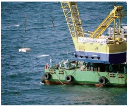
▲室蘭海域での水和固化体ブロック投入状況
