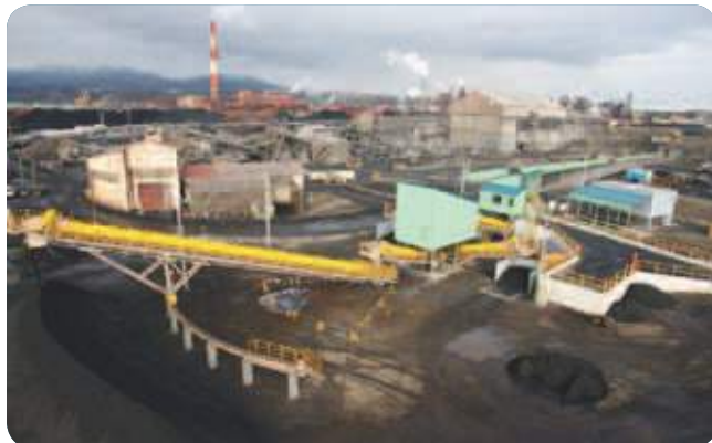
▲プラント設備据付
