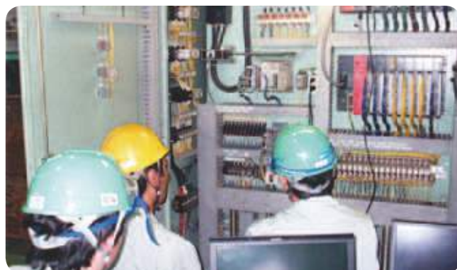
▲設備の試運転・試験
