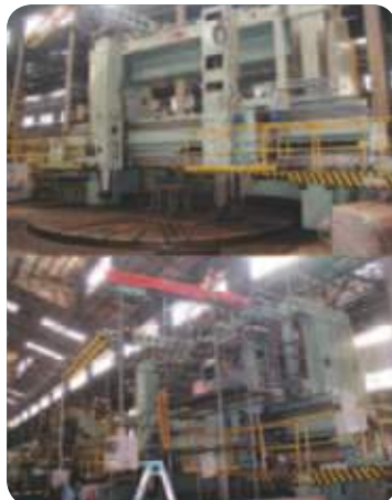
▲大型特殊盤解体移設工事
