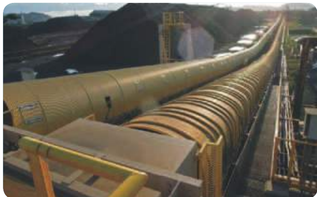
▲コンベヤ製作据付
