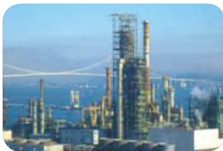
▲ナフサ水素化精製装置
