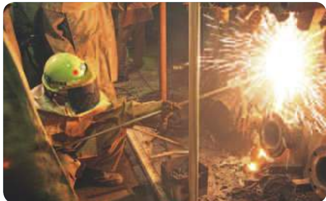
▲高炉改修ランス切断
