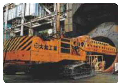
▲転炉及び鍋煉瓦解体機
