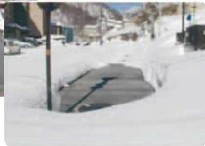
▲「ドライウェイ」を施工した舗道のようなす（登別温泉・冬季）
