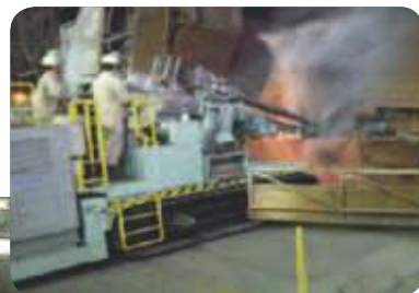
▲転炉出鋼孔煉瓦解体工事
