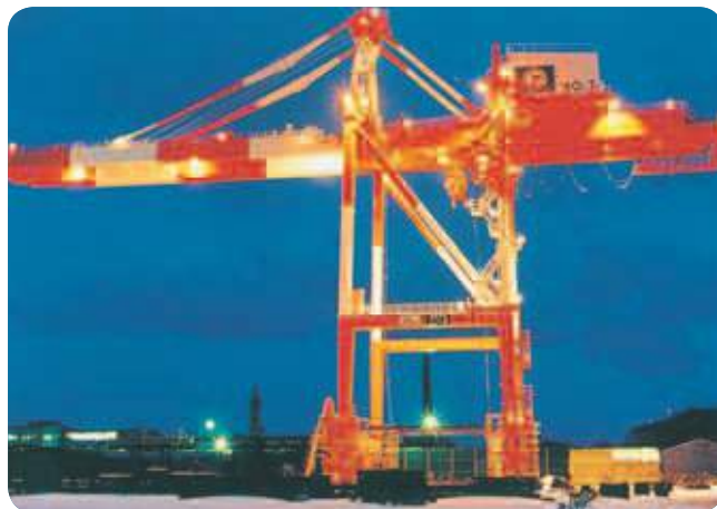
▲ローブトロリ式橋形クレーン
