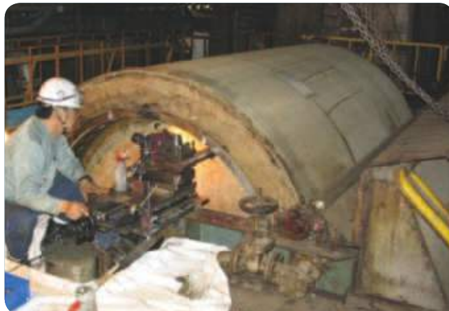
▲バルブ洗浄ドラムシート面現地加工
