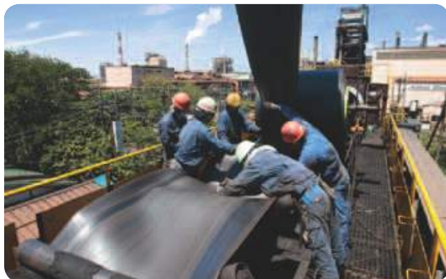
▲ベルトエンドレス施工
