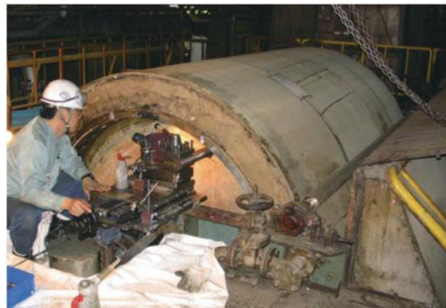
▲パルプ洗浄ドラムシート面現地加工
