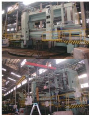
▲大型特殊盤解体移設工事
