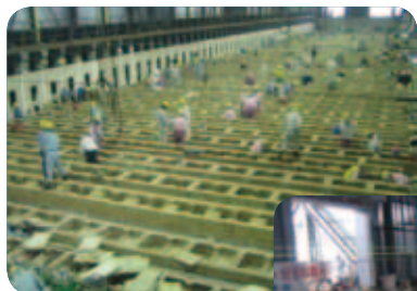
▲燃焼室煉瓦積
