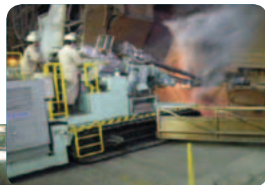
▲転炉出鋼孔煉瓦解体工事
