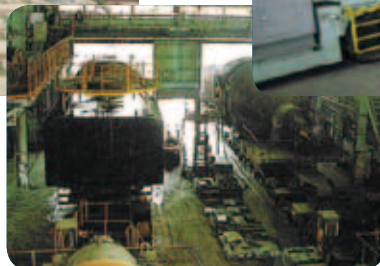
▲混鉄車煉瓦補修工事
