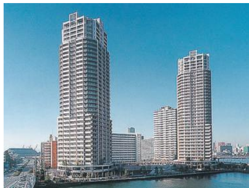
▲Pca大梁・小梁が採用されたビル(東京都豊州)
