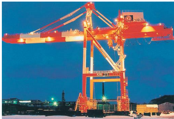
▲ロープトロリ式橋形クレーン
