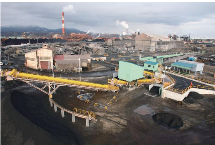
▲プラント設備据付
