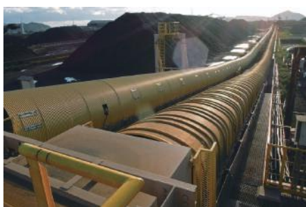
▲コンベヤ製作据付
