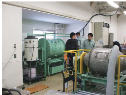
▲設備・施設の設計調査
