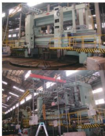
▲大型特殊盤解体移設工事
