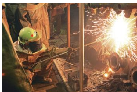
▲高炉改修ランス切断
