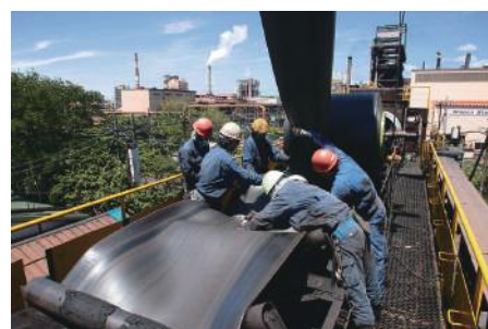
▲ベルトエンドレス施工
